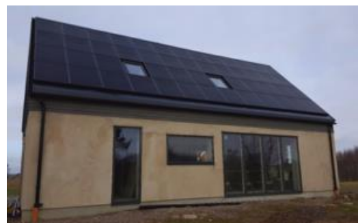
Solcellsanläggningen på Hässleberga 2:13, vinnare av Skåne Solar Award 2018
